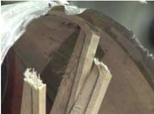
Figure 219 : Web damage.
